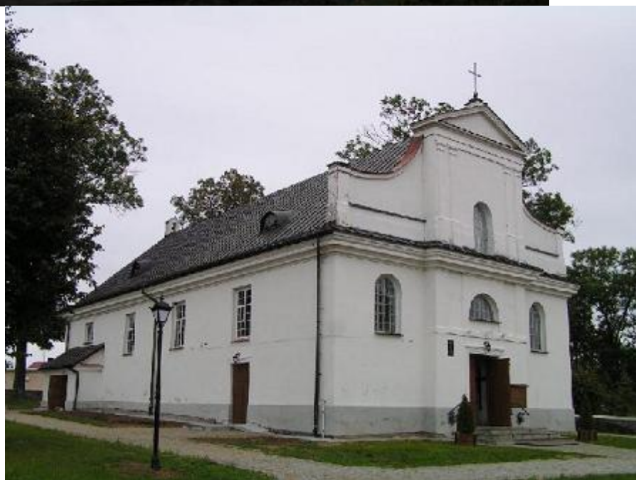
Kościół w Osmoli
